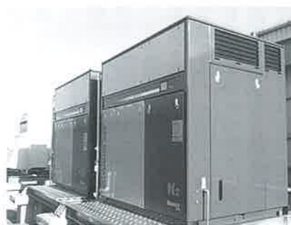
屋外設置可能で追加工事が少なくLGCからの置き換えのハードルが低い「GENE-BASE」22kWタイプ。99.99%40Nm 3 /hの供給が可能
