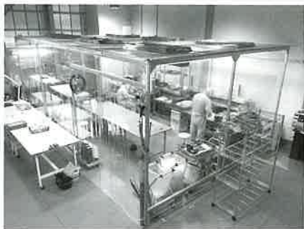
半導体用クリーン配管製作等のクリーンブース
